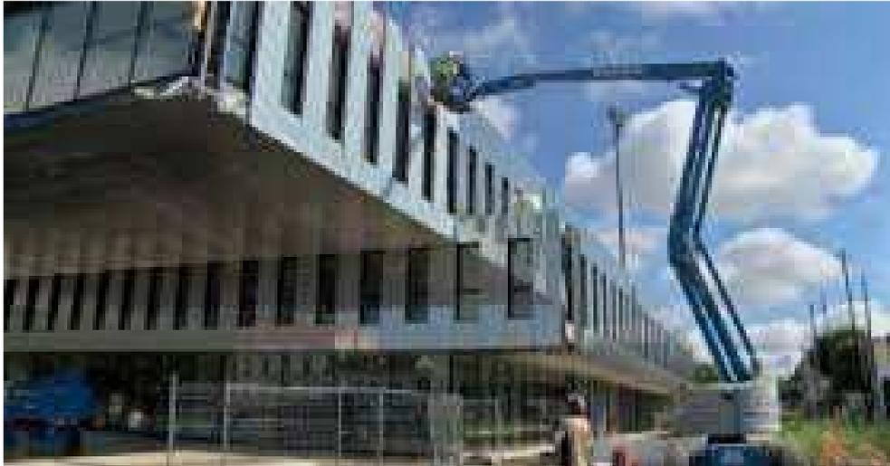
Le nouvel Hôtel de Ville présente un port a faux de 12 m (Largeur 30 m). Lors des opérations de construction, il est apparu que les calculs devaient être revus et les structures renforcées.
